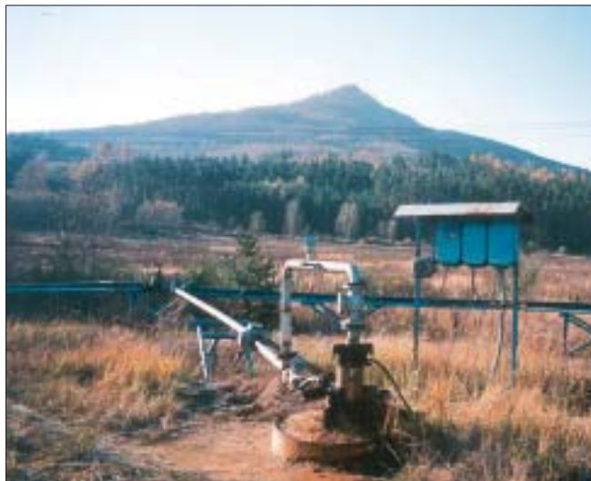
Obr. 7: Čerpací vrt se zapuštěným čerpádkem. Vyluhovací pole Stráž pod Ralskem
