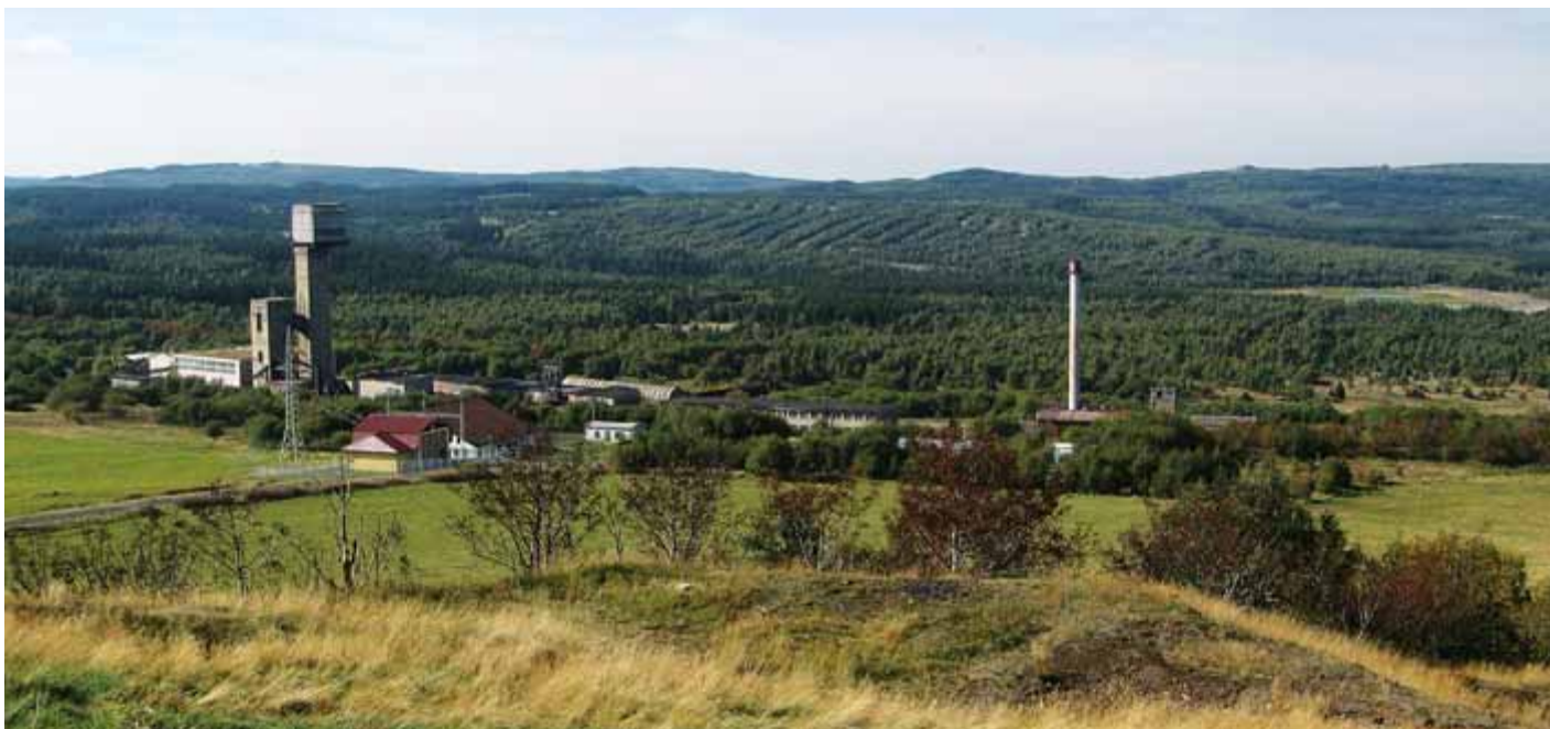
Obr.2 Důl Měděnec-celkový pohled
