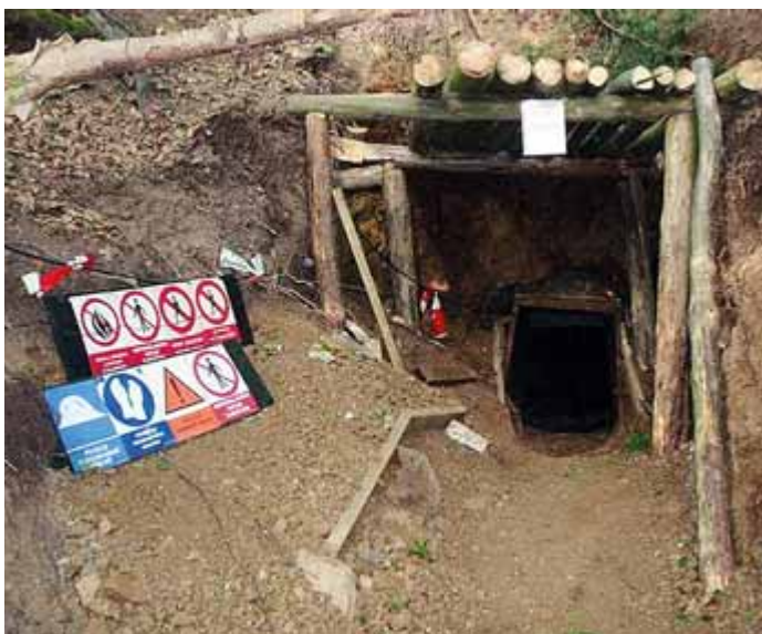
Obr.4 Obnovený portál vstupní štoly ve Vlastějovicích
