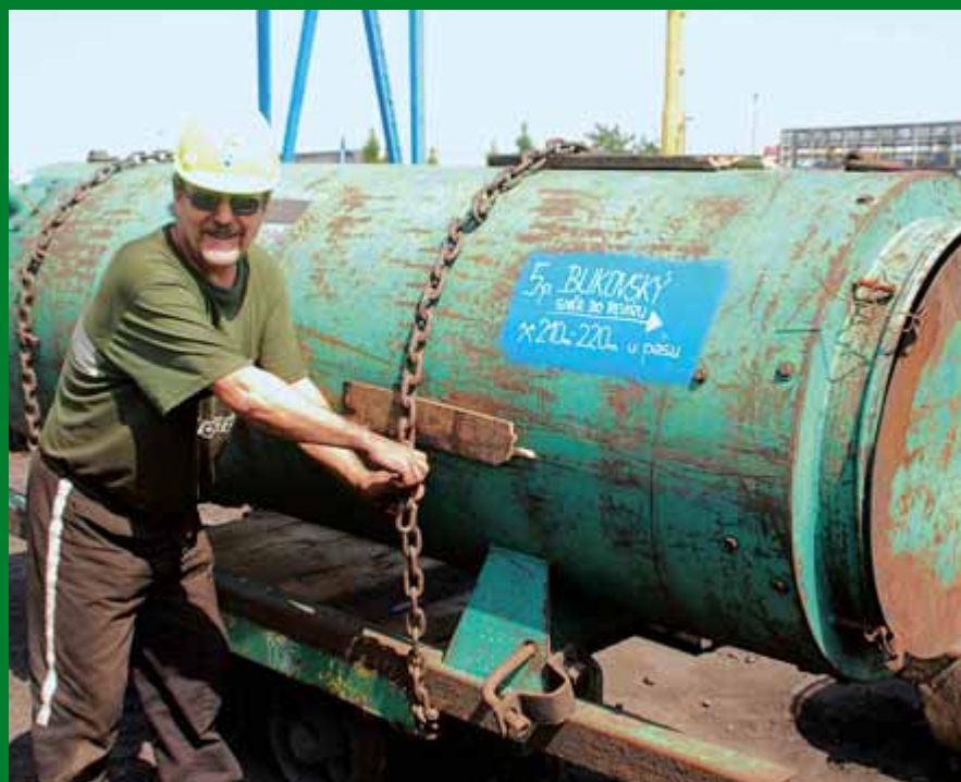
Oprava klimatizačních „ledniček“ na povrchu staříčské lokality.
